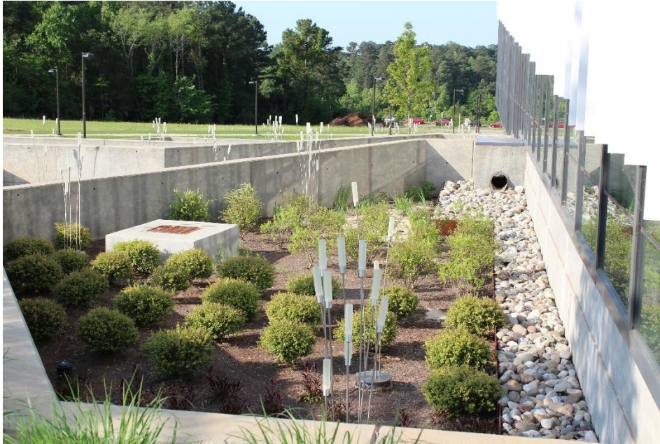
Figur 13 Dagvattenbiofilter. Bildkälla: Søberg, 2014.
