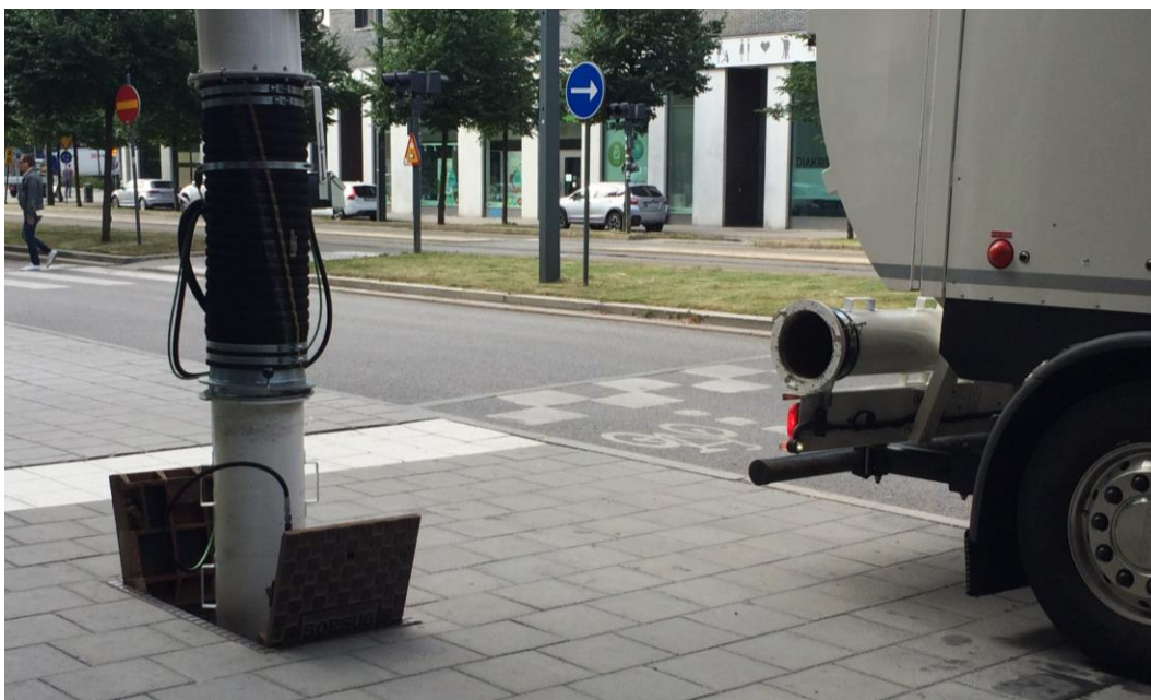
Figur 4-7 Dockningspunkt för mobilt sopsug, i detta fall placerad i gångbana.
