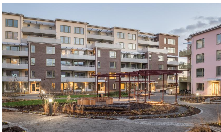
Figur 13-1. Avledning av takvatten till regnbäddar via rännदार anlagda i gatsten. Exempelbild från Linnéhuset i Uppsala (Uppsalahem, 2020).
