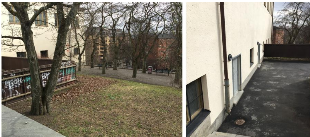
Figur 4. Utsikt från skolgården mot sydöst. Inhägnad kring asfaltsyta utanför annexet (gymnastiklokal) syns till vänster i bild (vänster bild). Annexets västra fasad samt inhägnad asfaltsyta. Takdaggvatten leds direkt på ledning utan rening (höger bild).
