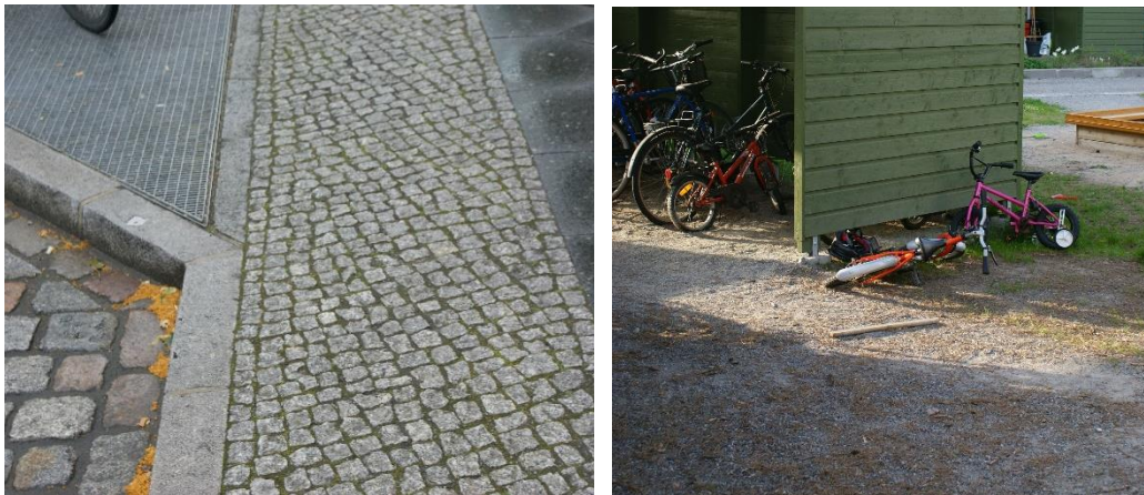
Figur 33. Exempel på permeabla beläggningar (Bild: Sweco).
