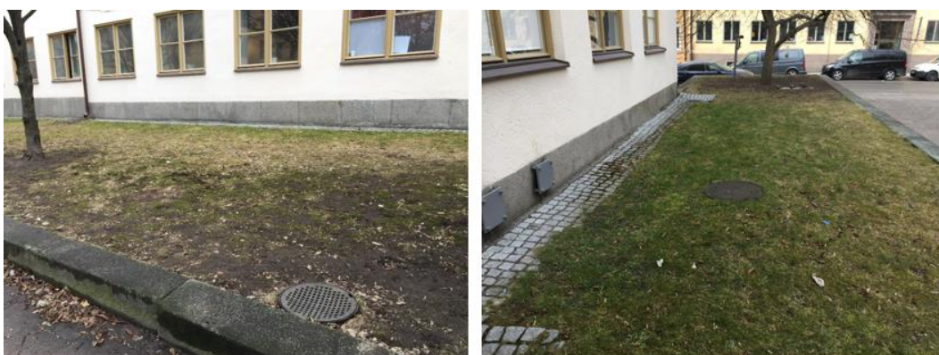
Figur 7. Skolans norra fasad mot Allhelgonagatan med omgivande gräsyta. Takdaggvatten leds ut och renas i gräsytan (vänster bild). Skolans östra fasad mot Älvsborgsgatan med omgivande gräsyta. Bilar parkerade på Allhelgonagatan syns i bakgrunden (höger bild).
