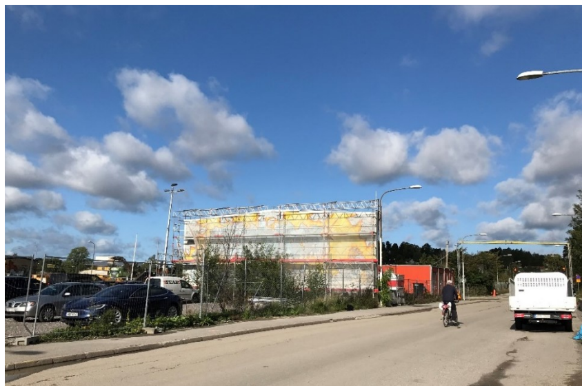
Bilder tagna 2019. Enbart väggen med målningen står kvar. Väggen stötts upp av en provisorisk stålkonstruktion.
