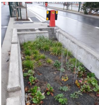
Figur 27 Regnbäck längs Neptunigatan i Malmö. Översilningsdjup ca 50 - 60 cm
