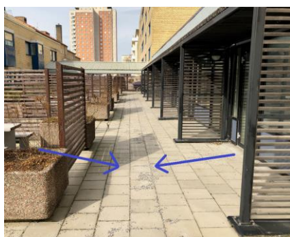
Figur 15 Svag lutning från fasad och innergårdens mitt till en avlång lågpunkt längs med fasaden där det sker avvattning via dagvattenbrunnar.
