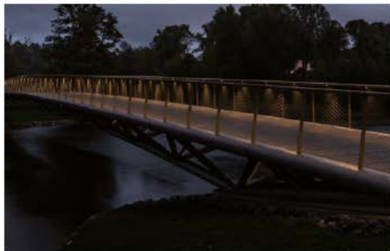
En ledstångsbelysning föreslås infästas i räcken utmed bryggorna.
