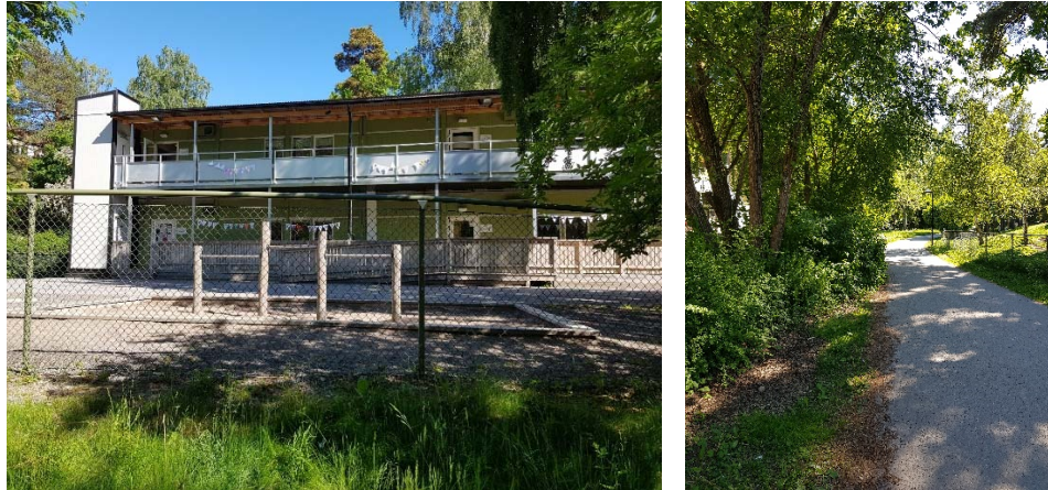
Figur 14. Befintlig paviljong sedd från gångvägen i väster.
