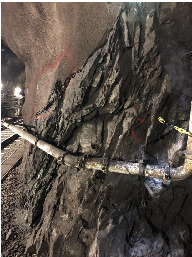
Figur 3. Gnejs i tunnel med tydlig foliation, skivigt parti.
