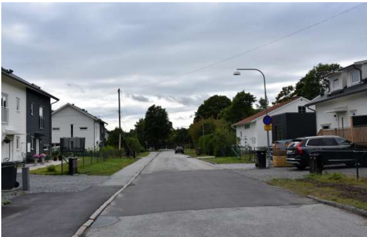
Figur 6. Attundavägen utsikt mot söder, mot Spångavägen. På vänster sida ses nybyggda parhus i kvarteret Lillskogen. Till höger i bild ses nybyggt parhus i kvarteret Prebendet 17.
