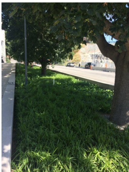
Fig. 11 Nedsänkt odlingsbädd, Perkolations/- fördröjningsyta med pimpsten och växtlighet (Norra djurgårdsstaden), foto Novamark
