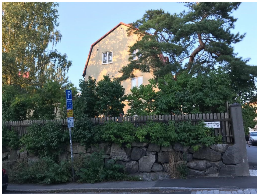
Befintlig byggnad inom fastigheten Lejongapet 15, sedd från Tegelbruksvägen.
