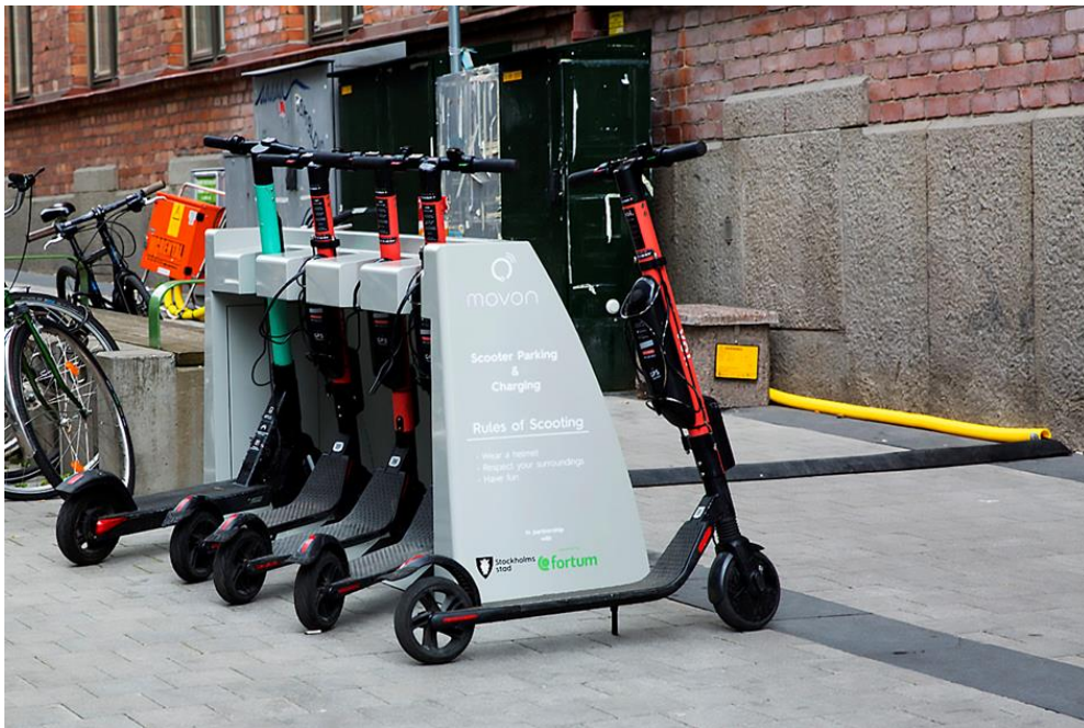
Figur 5-2 Exempel på elsparkcykelställ med laddmöjlighet i Stockholm (källa: internetfoto.se).
