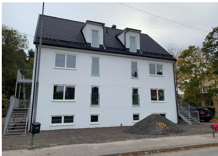
Befintlig bebyggelse mot gata på fastigheten Freja 8, Båtsmans Stens väg.
