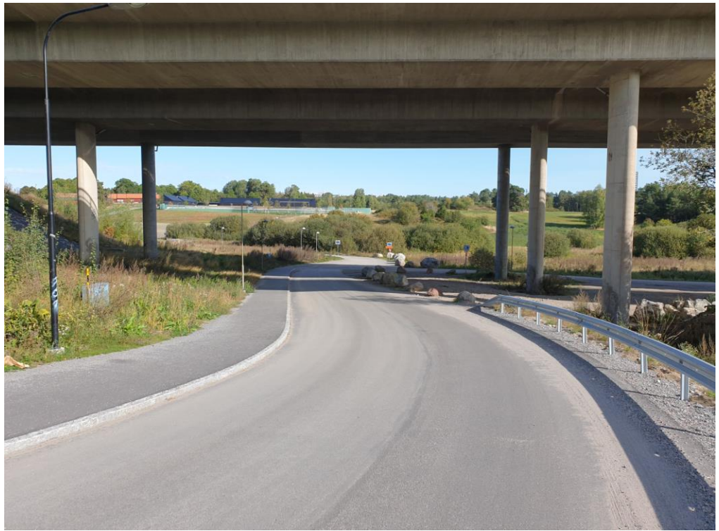
Figur 14 Skyfallsvatten från det norra avrinningsområdet leds längs vägen under bron
