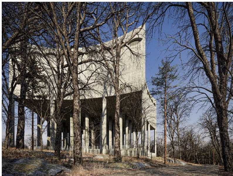
Vy från den nya angöringsvägen som utförs i genomsläppligt material.
