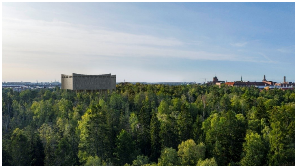
Drönbild mot sydväst. Den nya vattenreservoaren på Katrumpsbackens topp i Lill-Jansskogen.
