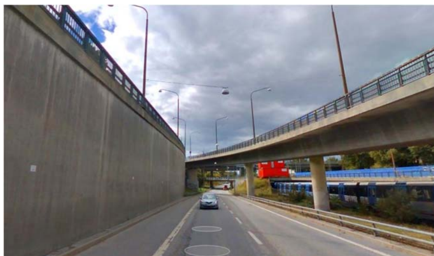
Figur 8. Vall mellan tunnelbana och Konradsbergshallen. Bilden är tagen från Drottningholmsvägen. Bild: Google Maps.
