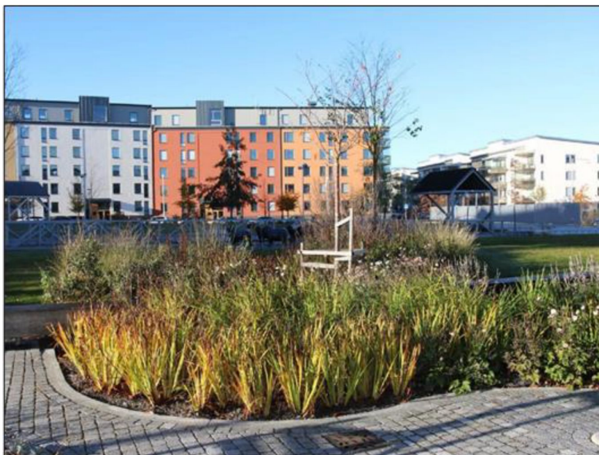
Figur 13 Exempel på nedsänkt växtbädd (Solna stad dagvattenstrategi, 2017)
