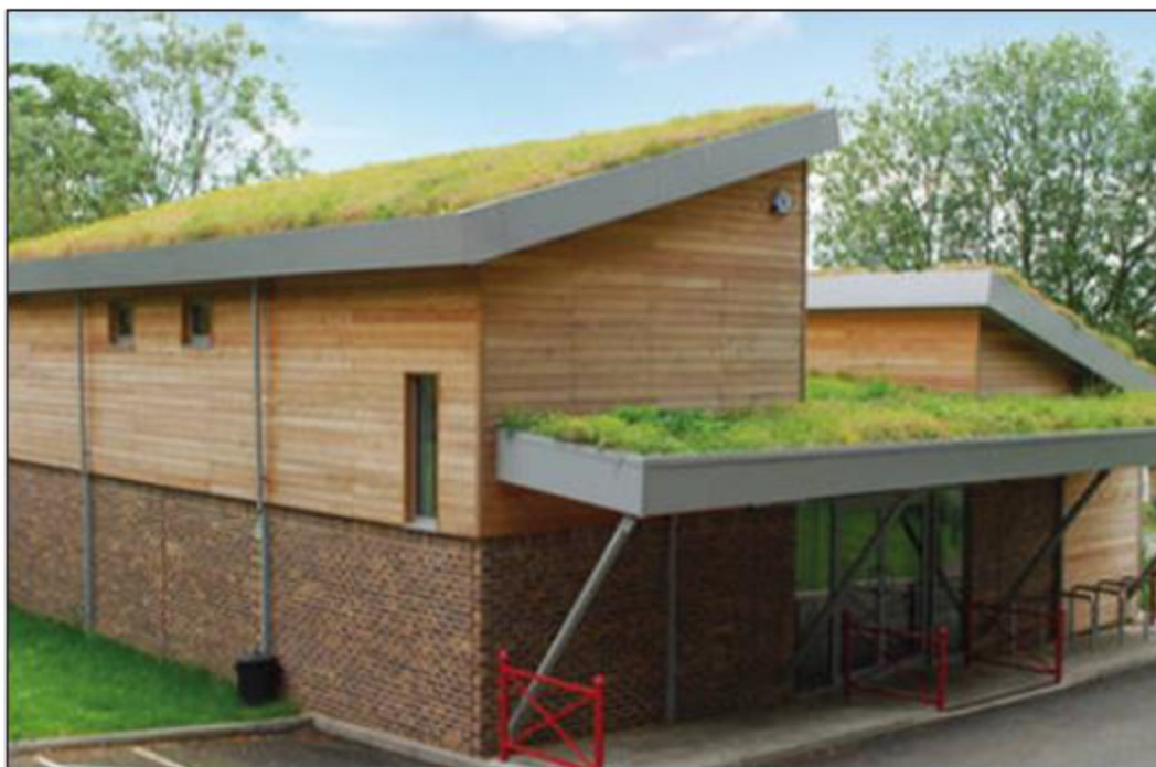
Figur 16 Sedumtak kan anläggas både på platta och lutande tak (Svenska Naturtak AB, 2018)
