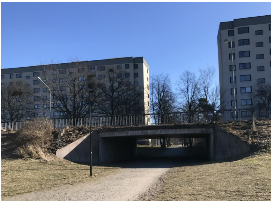
Figur 9 Gång- och cykeltunnel under Ålgrytevägen
