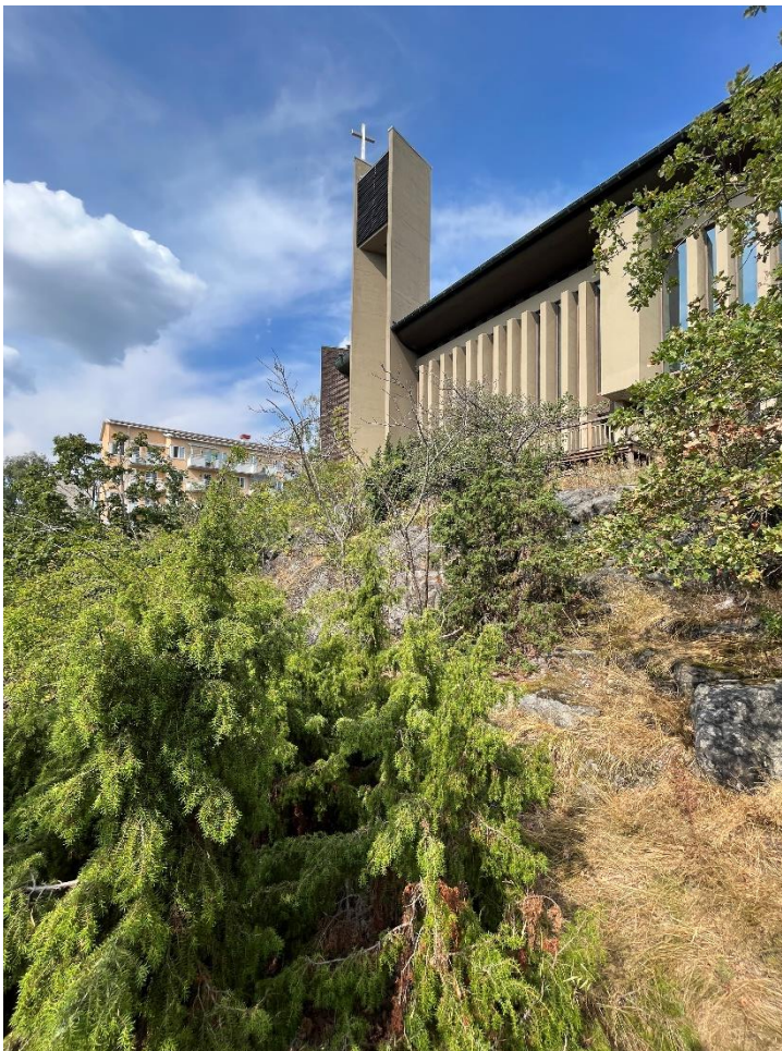
Hammarbykyrkan fasad mot sydväst, foto AIX augusti 2022.
