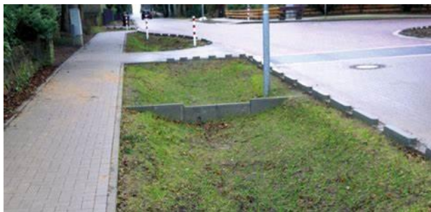
Figur 6-8. Exempelbild på ett svackdike placerat i nära anslutning till en hårdgjord yta som en dagvattenlösning. (Källa: Stockholm Vatten och Avfall).
