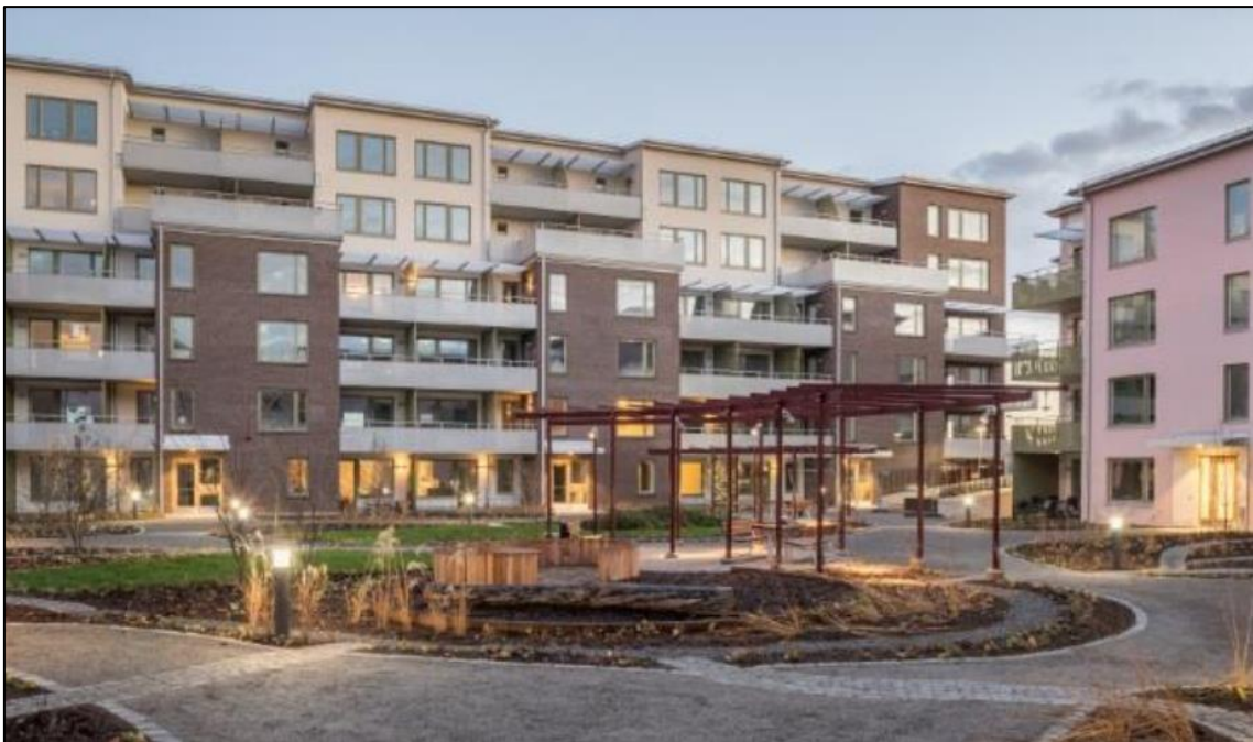
Figur 6-6. Avledning av takvatten till planteringar via rännalar anlagda i gatsten. Exempelillustration från Linnéhuset i Uppsala (Källa: Uppsalahem).
