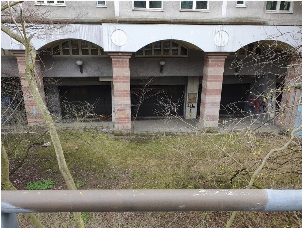
Figur 7. Gallerförsedda öppningar i husfasad mot spårområde Stockholm Södra på befintlig byggnad söder om planområdet. Vid skyfall innebär detta att vatten inte kommer att stå mot husfasad utan i stället rinna ner mot spårområdet. Foto från gångstråk norr om planområdet.
