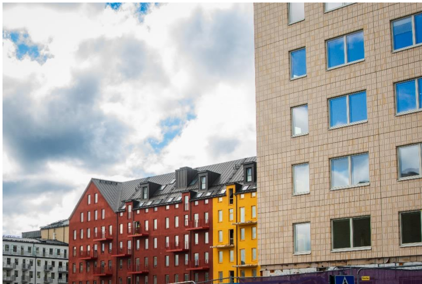
Delar av kvarteret Persikan under uppförande (SBK, 2023)
