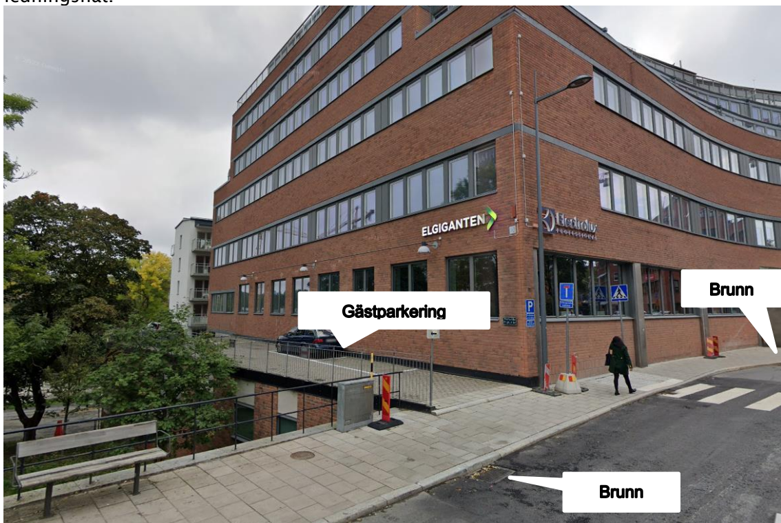
Figur 2. Fotografi taget av byggnadens sydvästra hörn längs Franzéngatan. Ytan som idag är en gästparkering kan nyttjas för dagvattenåtgärder. Två brunnar till dag- och spillvattenledning finns längs med Franzéngatan.
