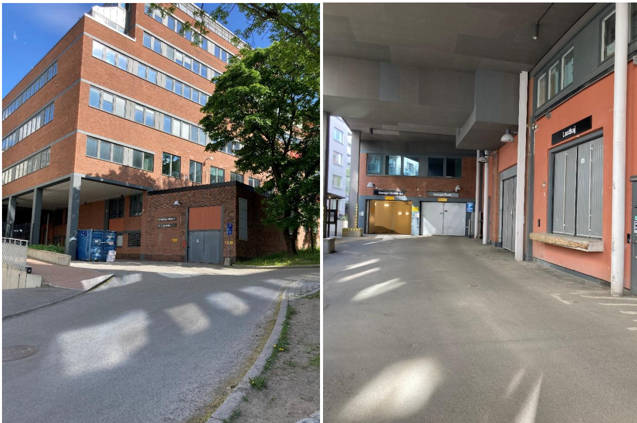
Figur 9. Väg till angöring. Till vänster bild på väg till lastkaj och garage. Till höger bild på lastkaj och infart till garage.
