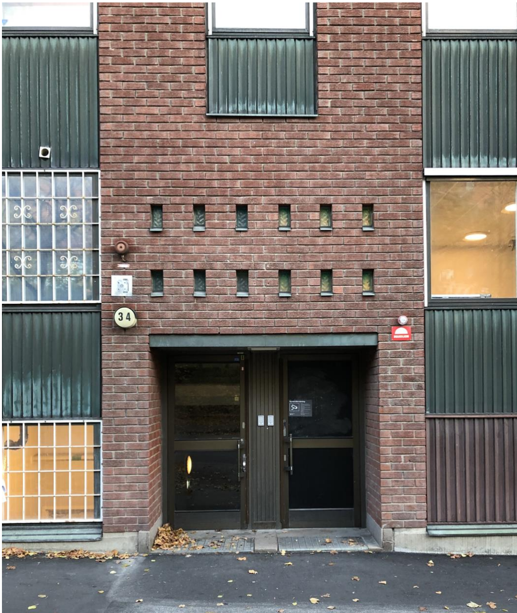
Bilden visar entrén mot Tellusborgsvägen med små, dekorativa öppningar. Foto: Studio Moi.
