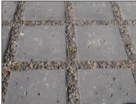
Figur 12. Exempel på genomsläpplig markstensbeläggning med grusfogar (VA-guiden).
