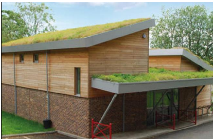
Figur 15. Gröna tak kan anläggas både på platta och lutande tak (Svenska Naturtak)
