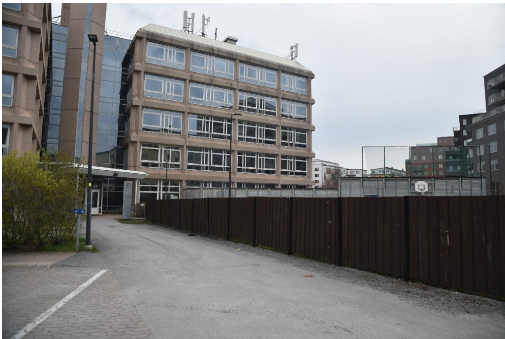
Figur 3. Godsfinkan 1, hus 3 närmst Sjöstadsskolan där skolverksamhet bedrivs idag. Foto: Ramboll.
