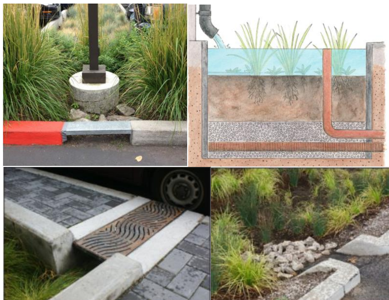
Figur 16. Exempel på utformning av inlopp till nedsänkta växtbäddar (SVOA, u.å.; VA-guiden, u.å.; Svenskt Vatten, 2019.b)
