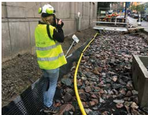
Dokumentation av nedvattning av kolmakadam i skelettskärv. Foto Hildegun Varhelyi.
