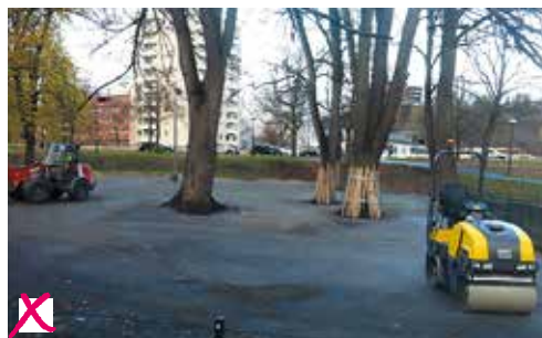
Ingen avspärning och inget skydd mot markkompaktering
