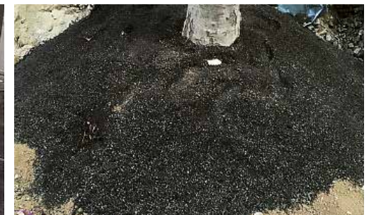
Årtäckning av rötter med kolmakadam.
