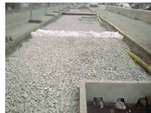
Dämmen av geotextil i luftigt bärlager.
