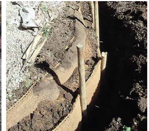
Fig. 3. Rottraperi av kokosmatta monterad mot träpålar samt fuktig jord. När återfyllnadsarbeten ej kan utföras omgäende skyddar rottraperiet trädrötterna från uttorkning.
