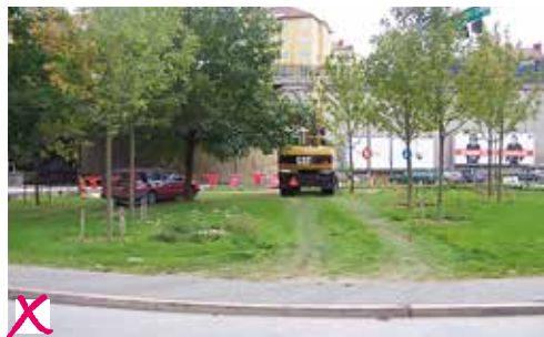
Ingen avspärning: uppställning av bil och fordon som vid upprepade tillfällen kört i rotzonen.
