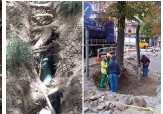
Tunnling av ledning under rötter med hjälp av vakuumschakt.
