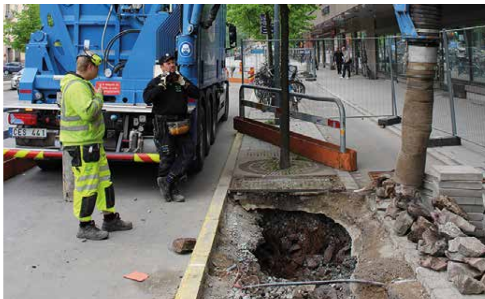
Provgrävning i skelettjord för utvärdering av rotutbredning.
