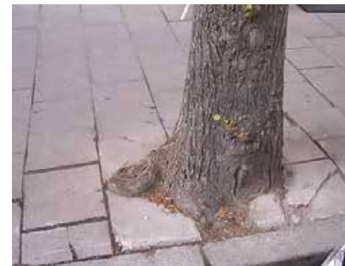
Beläggning som ansluter allt för tätt mot stam.
