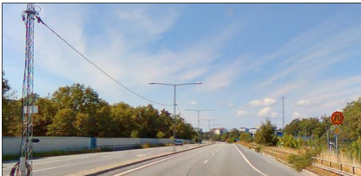
Figur 4-3. Magelungsvägen är en tvåfilig 70-väg med refug i mitten och cykelbana längs norra sidan (höger i bilden), längs den södra sidan (vänster i bilden) löper en stödmur (Källa, Eniro karta).
