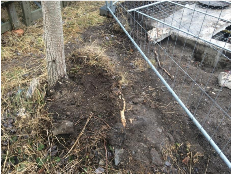
Figur 1. Träd nr. 2 - Schaktskador på rotsystemet.
