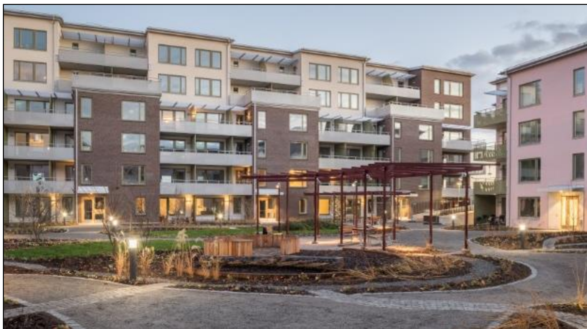
Figur 6-2. Avledning av takvatten till planteringar via ränndalar anlagda i gatsten. Exempelbild från Linnéhuset i Uppsala (Källa: Uppsalahem).
