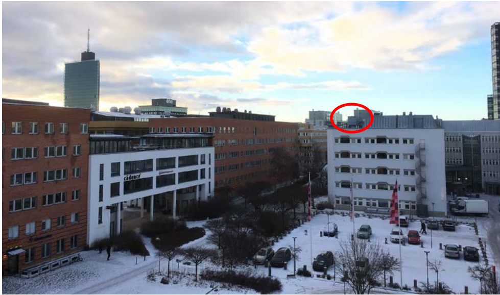
Figur 4. Takinstallation sett från Memory Hotel. Inringat är kylmedelskylare.
