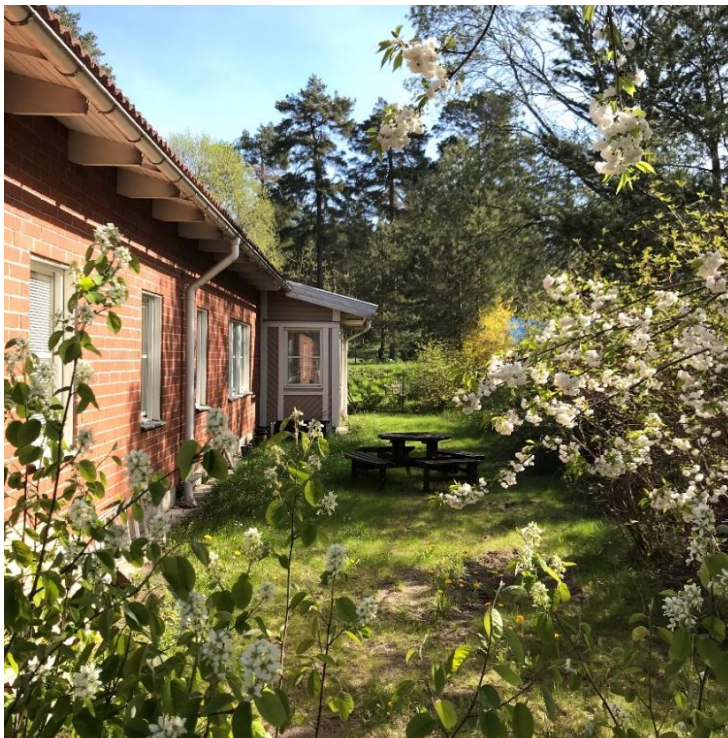
Figur 4. Vy över sydöstra delen av planområdet vilket är en lågpunkt och riskerar att bli översvämmad i dagens läge. Till höger i bild vid buskage finns idag en höjdrygg.
