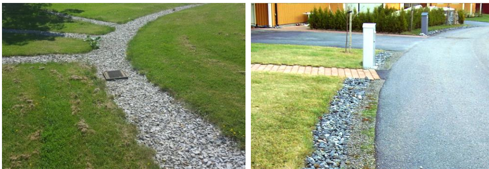
Figur 15. Exempel på makadamdiken. Källa: Ramboll, 2016 & SVOA, u.d.
