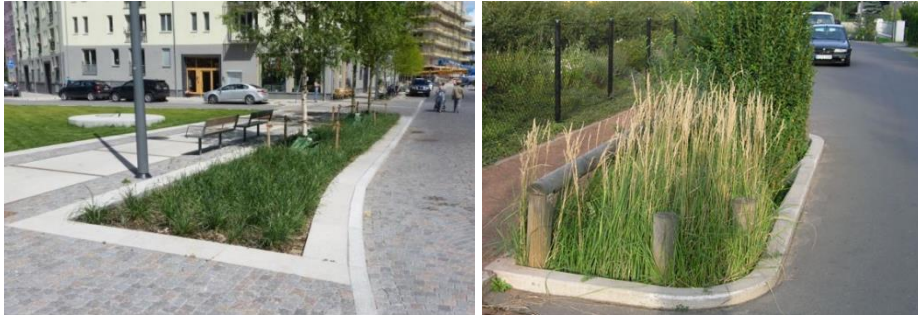
Figur 13. Exempel på utformning av nedsänkta växtbäddar. Källa: SVOA, u.d.
