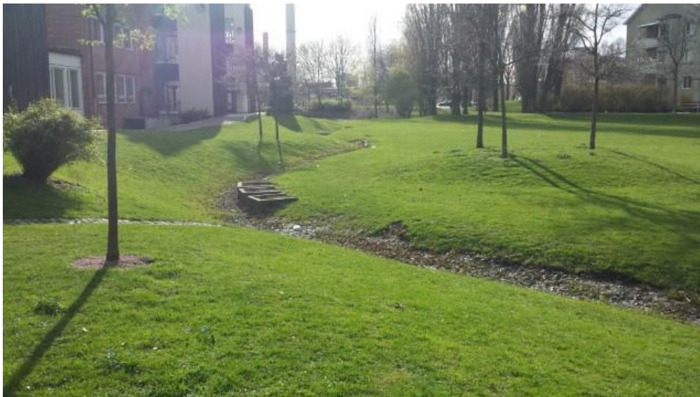
Figur 14. Möjlig utformning av svackdike. Källa: Ramboll
