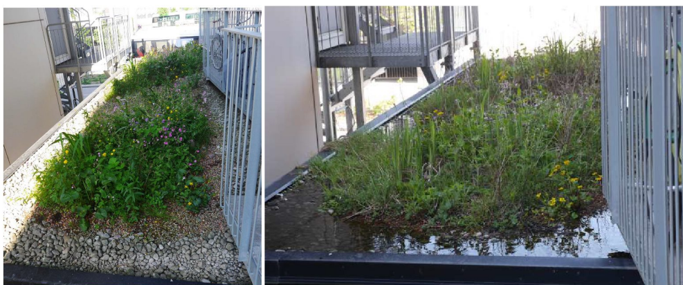
Figur 4. Visar en regnbädd på en takyta med 120 mm uppdämd vattennivå vid fastigheten Oh Boy i Malmö. Foton tagna juni 2018 under torrperiod (t.v.) och maj 2020 (t.h). Bild: Jonatan Malmberg
