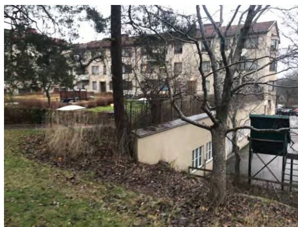
Figur 3. Innergården på garagebjälklag till vänster och garageinfart på den nedre nivån till höger.
