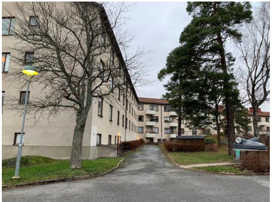
Figur 7. Gångbana på västra sidan om innergården.
