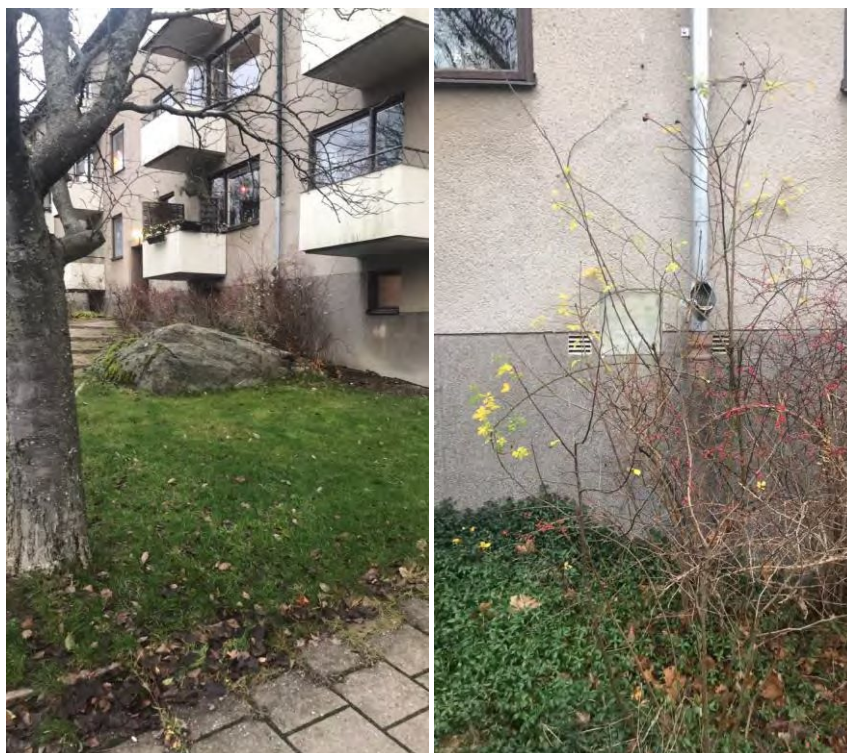
Figur 18. Stuprören på husfasaden.
