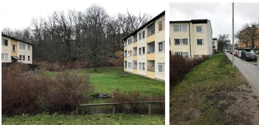
Byggnaderna är placerade med gavlarna mot gatan med öppna bostadsgårdar som möjliggör kontakt mellan Gustav III:s väg och Tunnländsparken. Förgårdsmarken består av gräsytor mot gatan.
