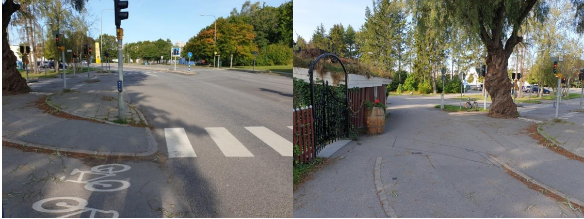
Figur 13 Korsning Bägersta Byväg/Sockenvägen
