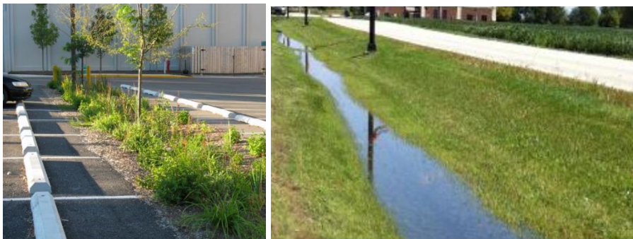
Figur 23 Grus- och barkfyllt svackdike (t.v.) och gräsdike (t.h.)
