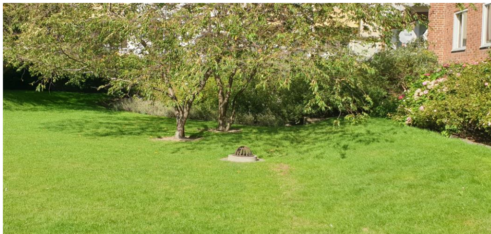
Figur 21 Stor nedsänkt innergård i Augustenborg, Malmö, som kan ta emot stora volymer dag- och skyfallsvatten. Ett upphöjt bräddavlopp ser till att mindre regn infiltrerar utan att nå dagvattenledningarna
