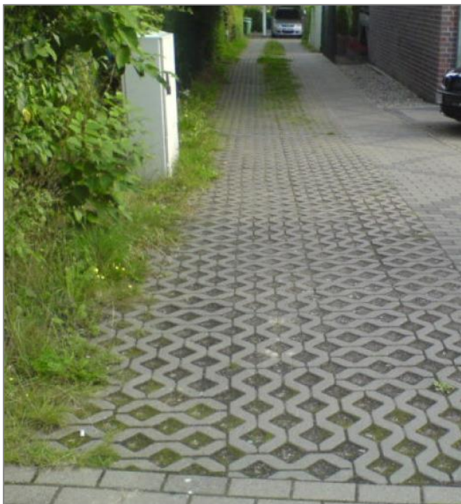
Figur 5-2. Exempel på genomsläpplig beläggning i form av gräsarmerad betongbeläggning (Stockholm Vatten och Avfall, 2017).
