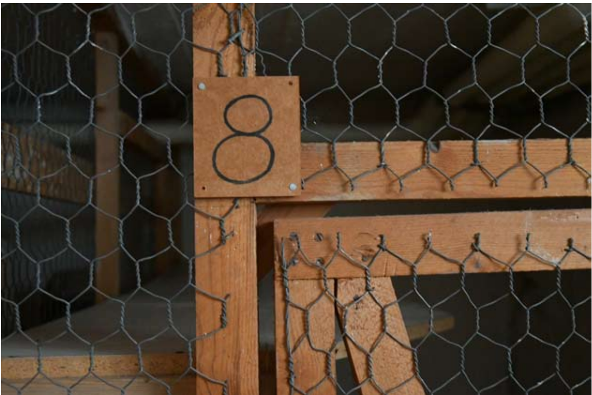
Detalj av nätvägg i förråden i källaren.
