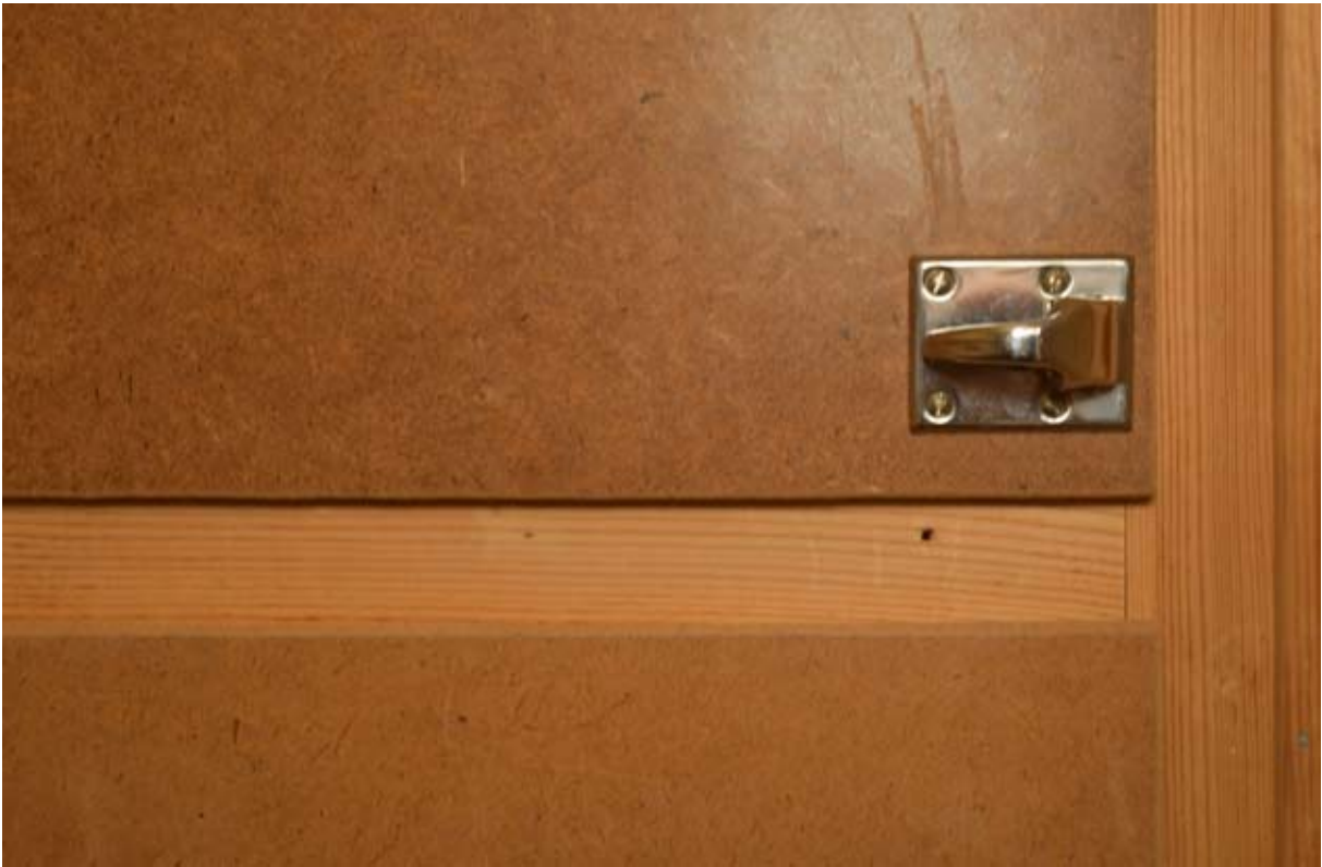
I ballens förråd finns skåpsinredning med furustommar och överfalsade luckor i masonite. Här har även skåpreglarna bevarats.
