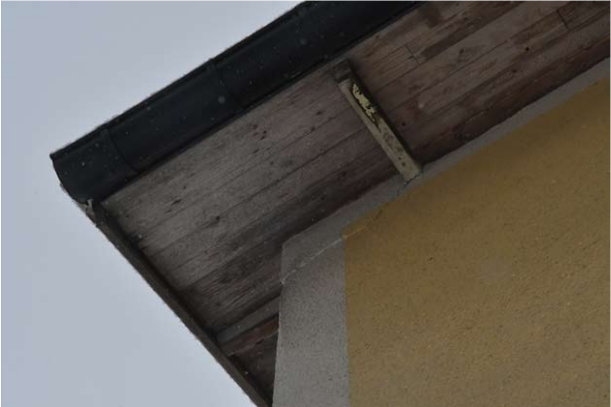
Detalj av takfoten med tunna taksparrar som bär underlagstaket.
