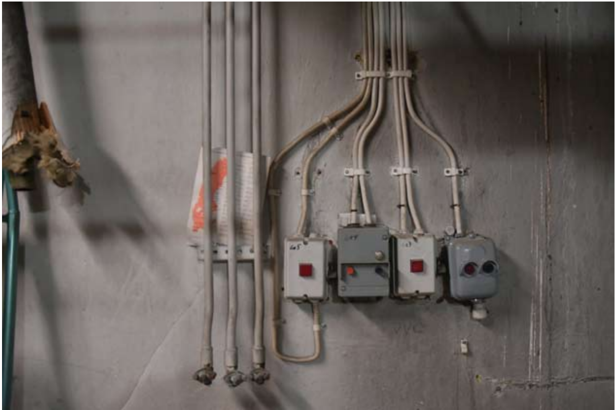
Detalj av vägg i undercentralen.
