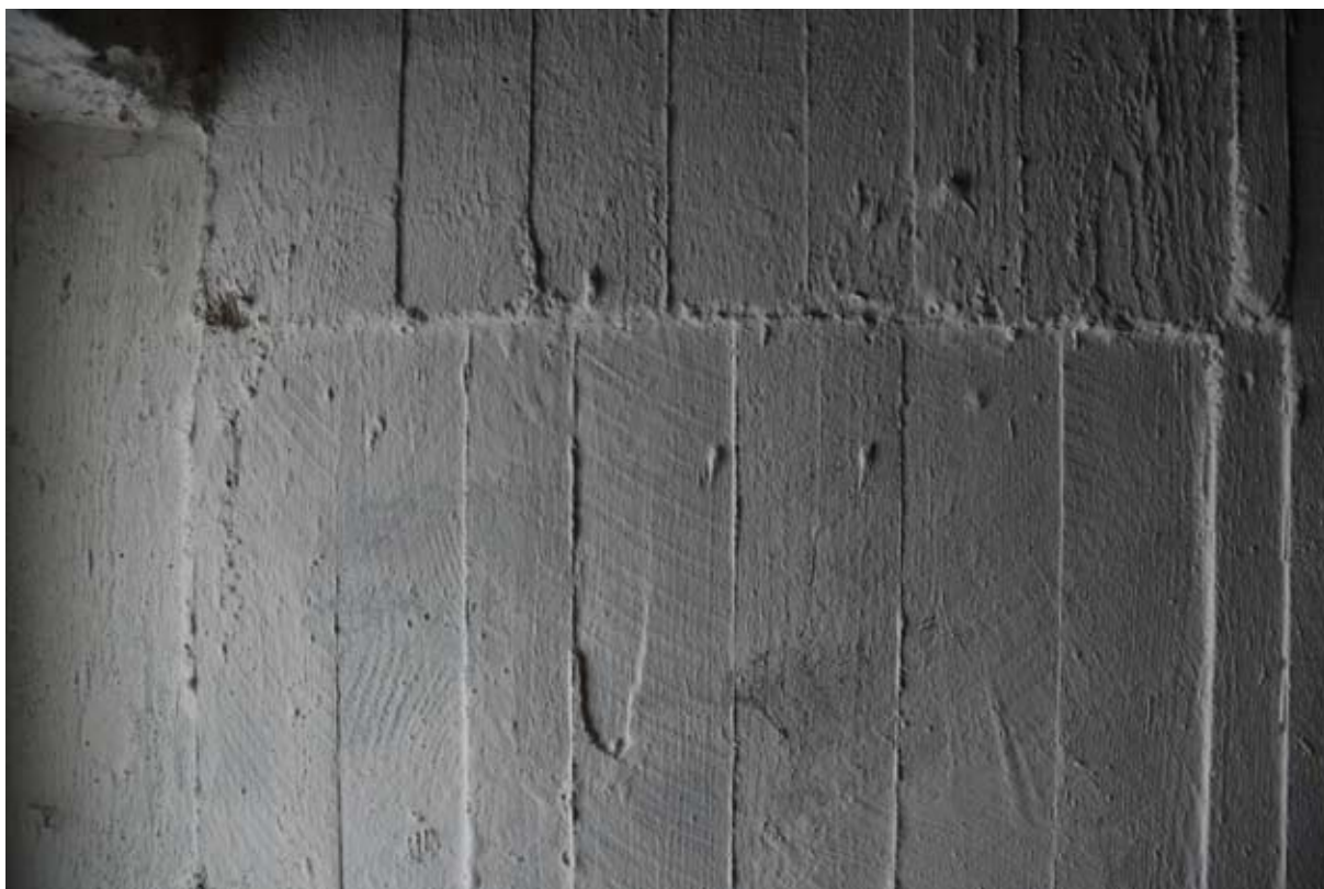
Bjälklag över källaren i platsgjutet betong med spår av brädformen.
