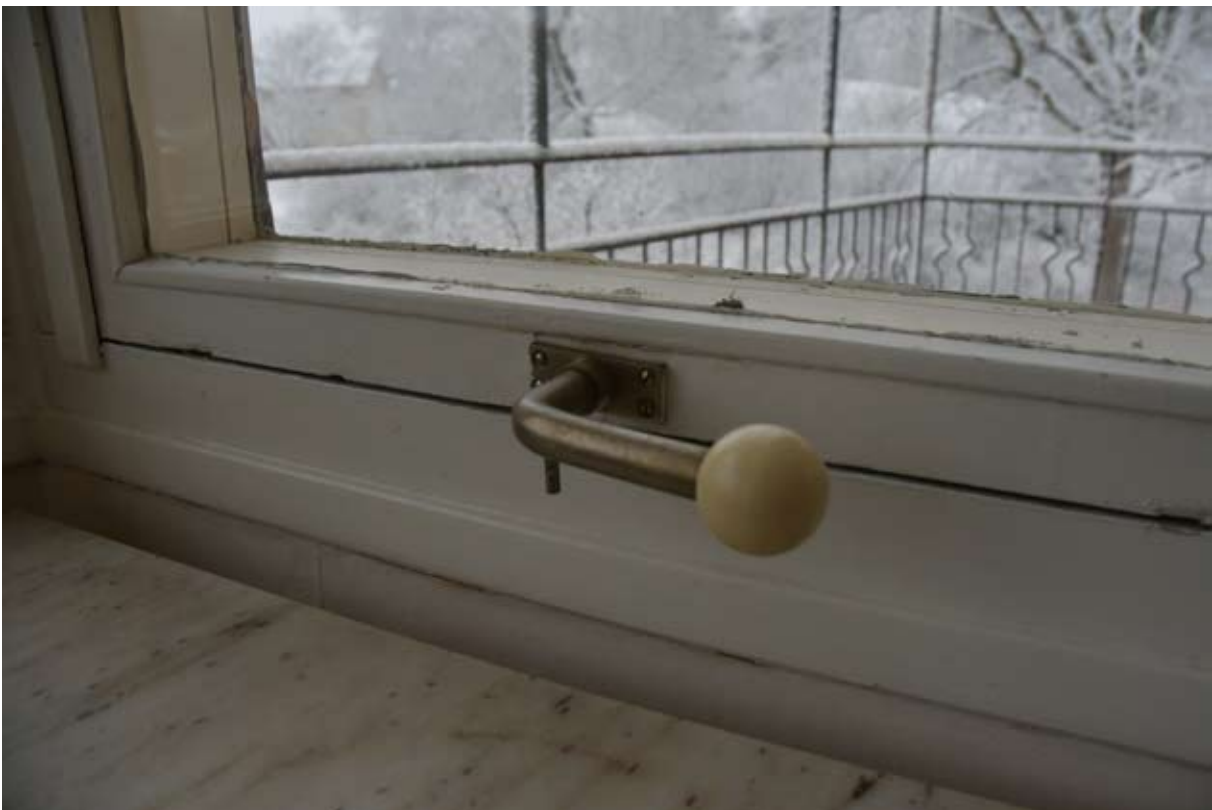
Burspråkets fönster är pivothängda Åtvidbergsfönster. Dessa kan reglas på glänt med dessa originalbeslag.
