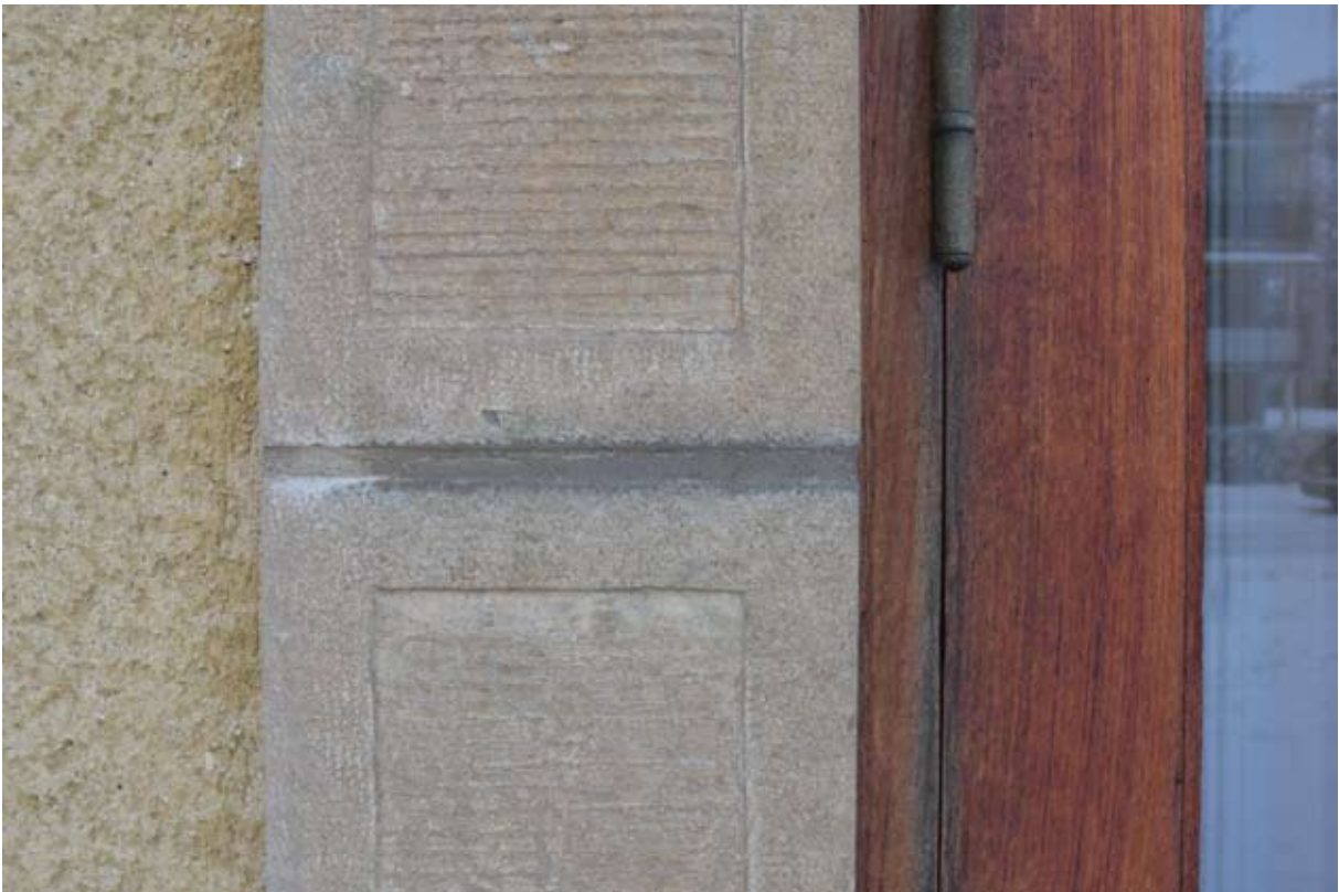
Detalj av fasad med ädelputs, omfattning i gotländsk kalksten och dörrblad i teak.
