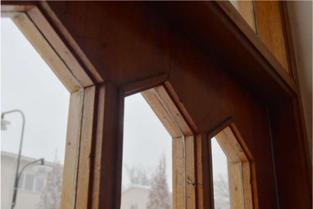
Insidan av ytterdörren med elegant utformade snickerier.
