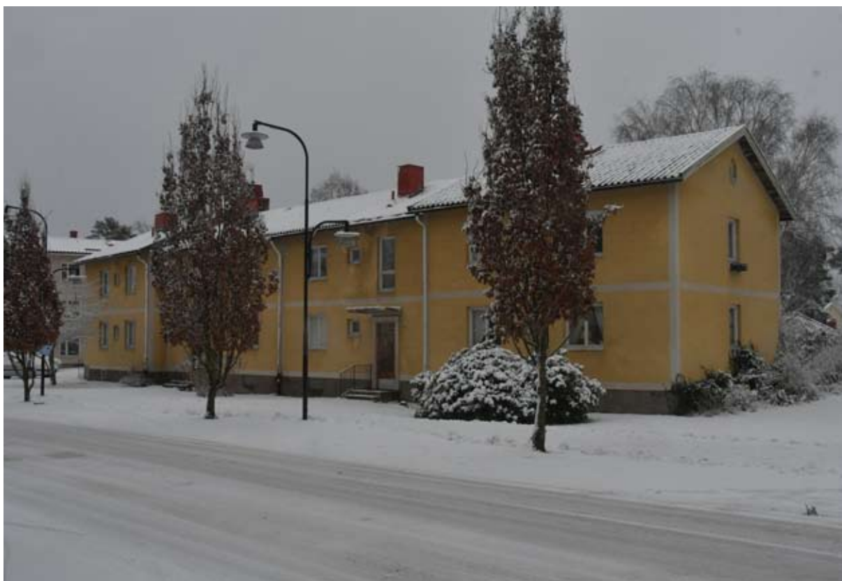
Fasaden mot norr med tre förskjutna byggnadskroppar. Fasaden är indelad med vita putslinjer som markerar bjälklagsläget. Framför huset en gräsmatta och träd.
