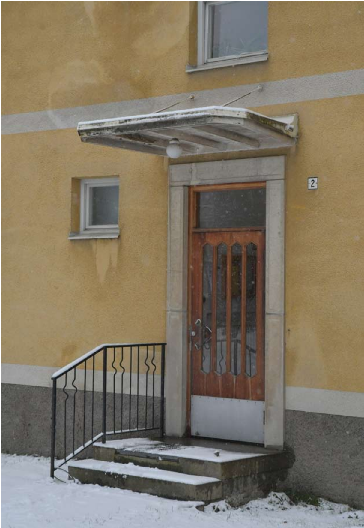
Entréerna har stentrappor, smidesrücken samt omfattningar i sten. Över dörrbladet i teak med tidstypiska rombformade glas ett tunnt skärmtak uppbängt på metallstap.
