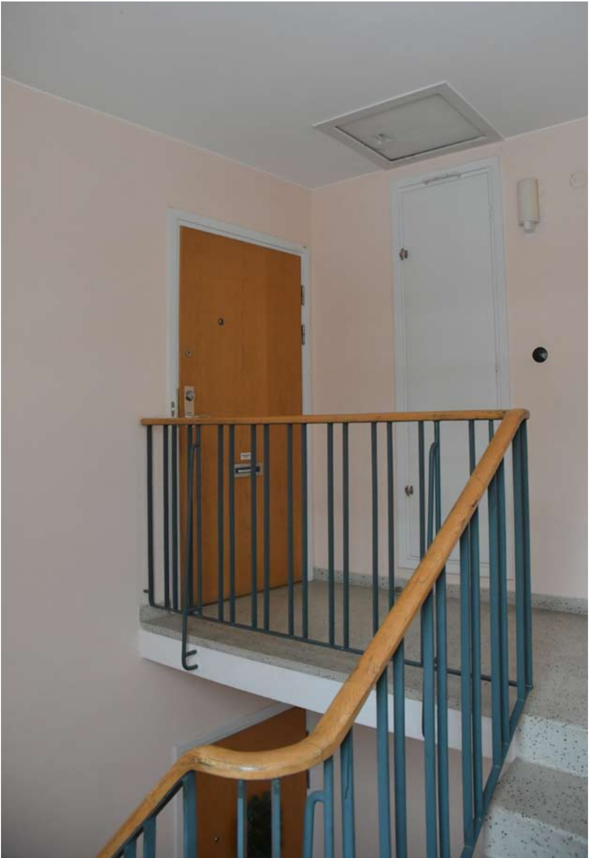
Trapplopp med smidesrücke med överliggare i ek, trappa och vilplan med terrazzogolv.
