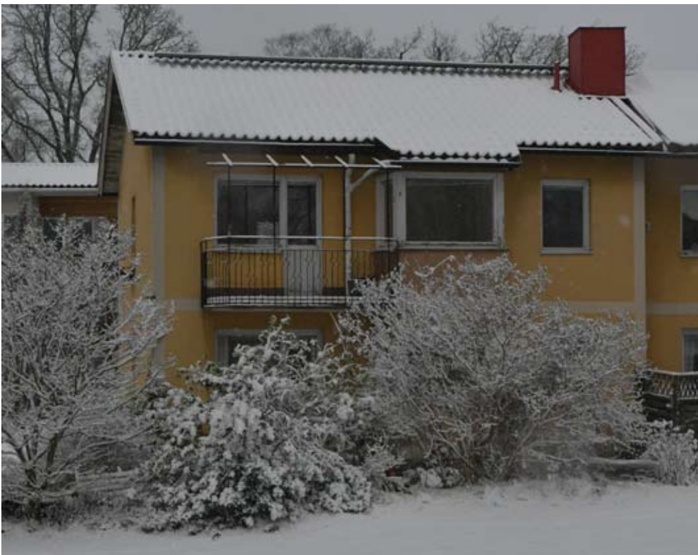
Del av södra fasaden, genom indelningen i olika byggnadskroppar bildar varje lägenhet en egen volym. Notera det eleganta smidesröcket och burspråket med snedställda sidofönster.
