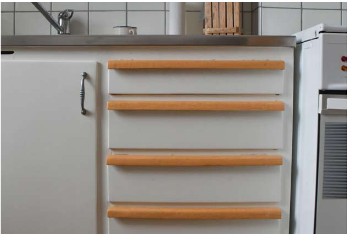
Detalj av köksinredning med lådburts med dragbandtag i trä. Handtaget på den överfalsade skåpsluckan är sekundärt. Här har ursprungligen suttit en skåpregel, typ snabelbeslag/ticka.
