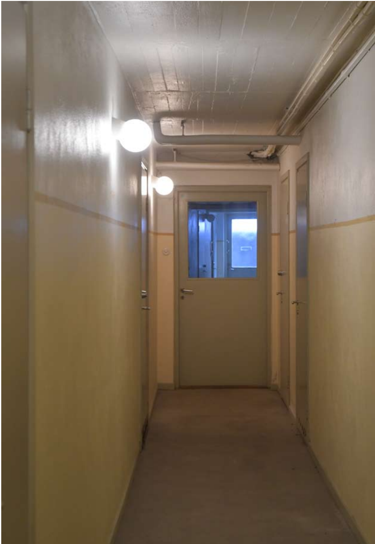
Källarkorridor med dörrar till tvättstuga och torkrum. Notera siktlinjen ut. Utrymmena bevarar den ursprungliga inredningen och karaktären i mycket hög grad, och har således en hög autenticitet.
