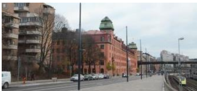
Foto av Torsgatan blickandes mot sydost med flerbostadshuset inom Silverskopan 3 längst till vänster i bild, Öskaret 1 i mitten och till höger i bild
