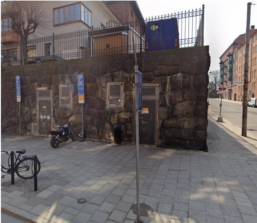
Bild: Entré till befintlig inhyest nätstation i fastigheten, Google Streetview.
