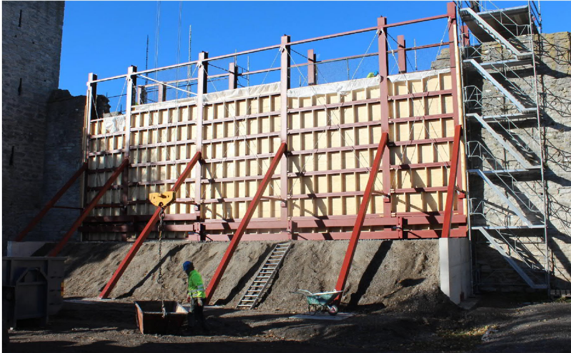
Bild 1. Exempel på temporär stödkonstruktion. (Visby ringmur. Foto Carl Thelin)
