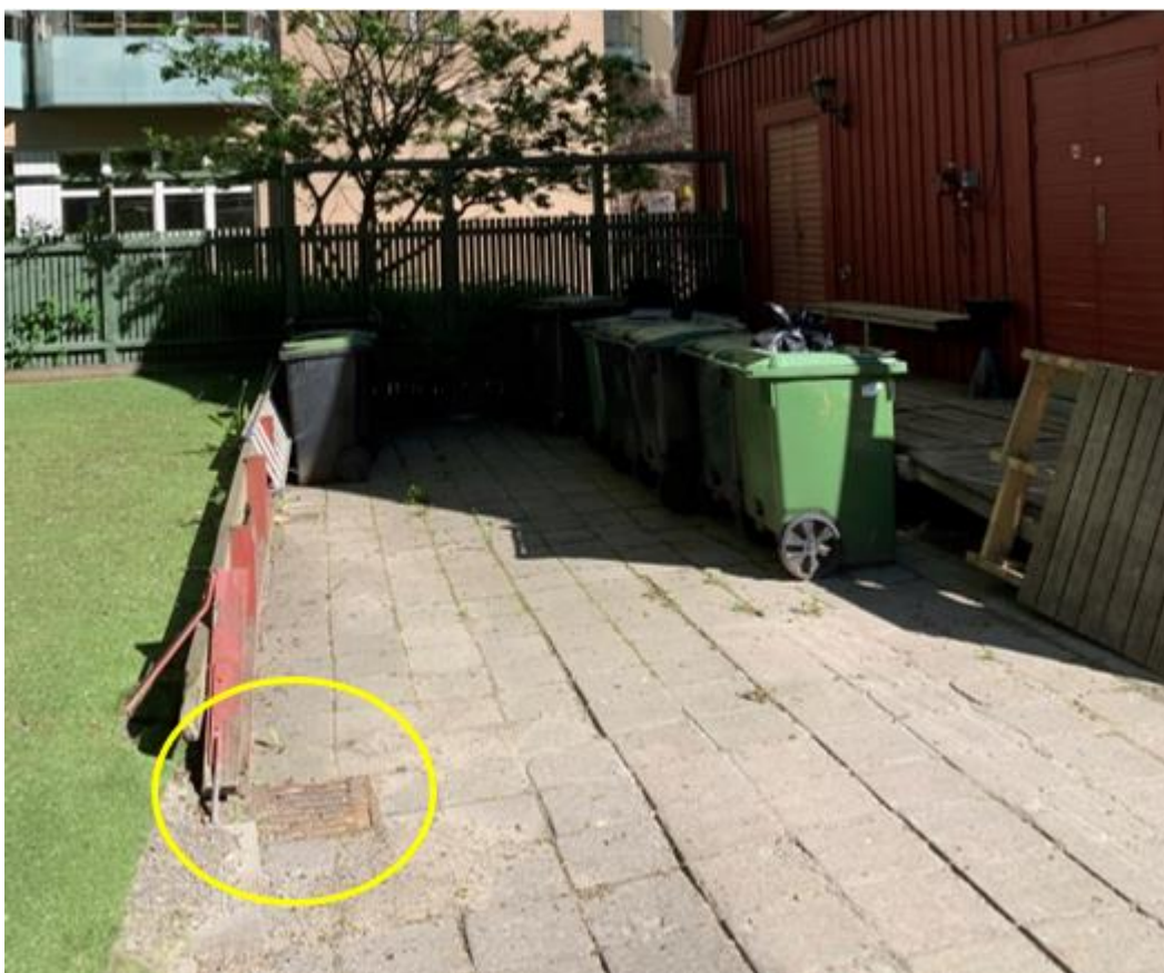
Figur 7. Dagvattenbrunnen på innergården som är idag igensatt är markerad med gul ellips i bilden.
