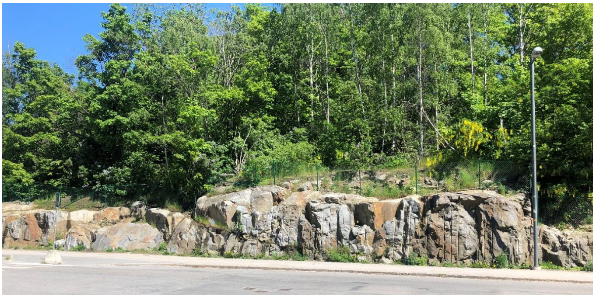
Figur 5-2. Blockigt berg vid befintlig bergslänt längs Tappvägen.
