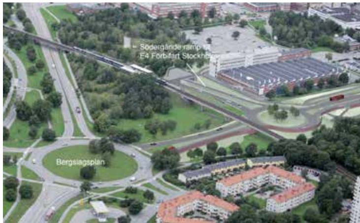
Förbifart Stockholms södra cirkulationsplats (t.h.) samt befintlig cirkulationsplats vid Bergslagsvägen/Lövstavägen (t.v.).
