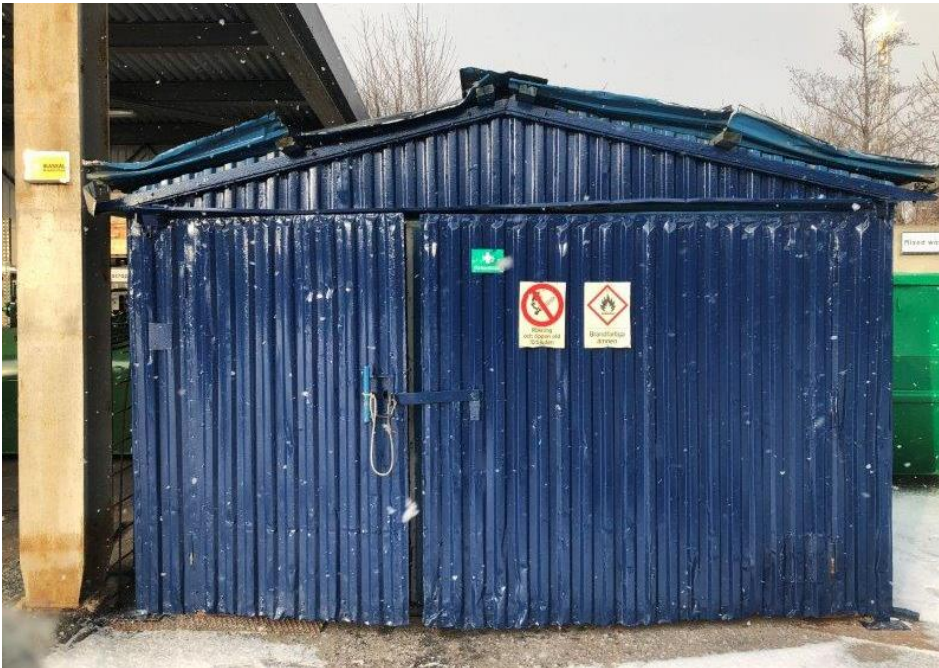
Figur 5. Skjul för förvaring av brandfarliga ämnen.
