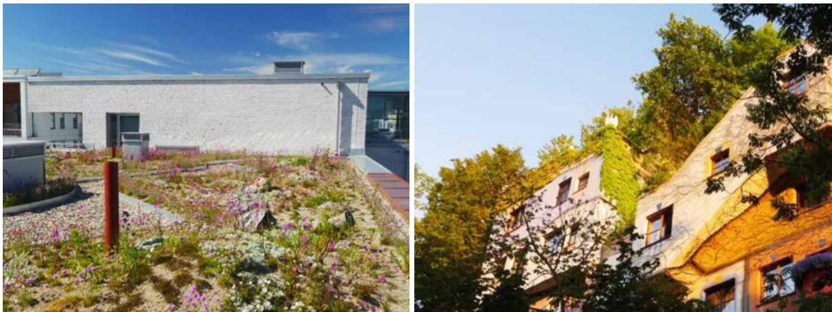
Figur 32 Extensivt sedum-ört-tak (t.v.) och intensivt tak med träd, Hundertwasserhaus (t.h.) (Grönatakhandboken)
