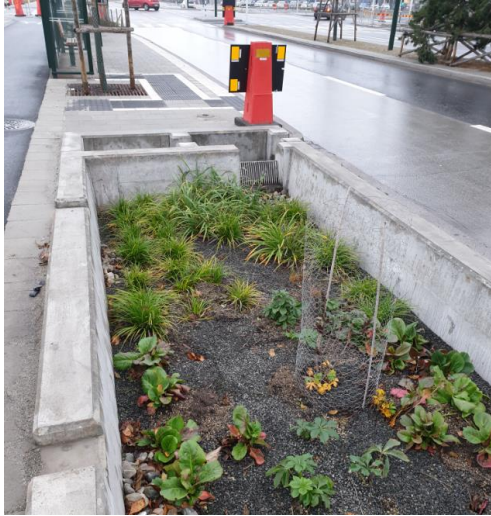
Figur 33 Regnbädd längs Neptunigatan i Malm, översilningsdjup ca 50 - 60 cm (t.v.) och principskiss regnbädd (Water Revival Systems) (t.h.)
